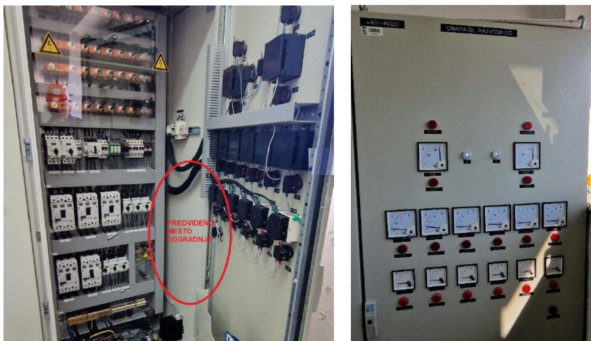
Slika 3 – Označeno mesto predvidene dogradnje odvodov na stranici v omari =A01 +N/DC 220 V DC in desno izgled opreme na vratih
