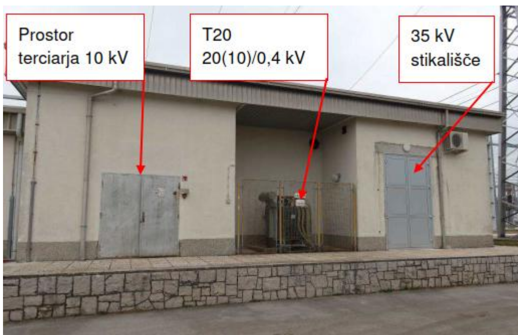
Slika 1 – hiša lastne rabe, kamor bo nameščeno novo 20 kV stikališče v sedanji prostor terciarja 10 kV
